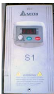
ภาพประกอบ 32 เครื่องควบคุมความเร็วรอบพัดลมเป่าอากาศ
