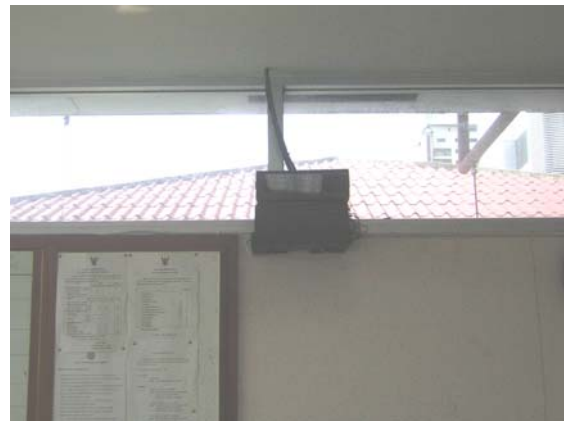
การติดตั้ง Charge Controller DC/AC Inverter และ Automatic switch
