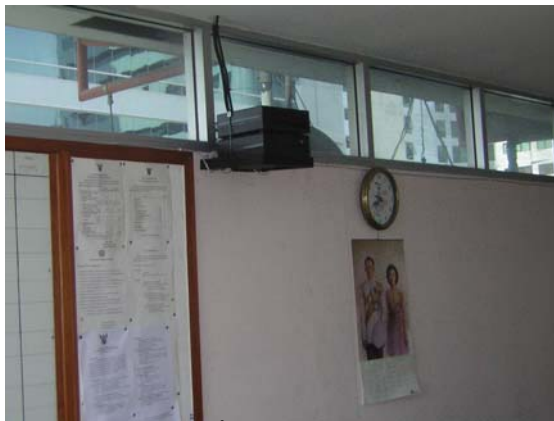
การติดตั้ง Charge Controller DC/AC Inverter และ Automatic switch
