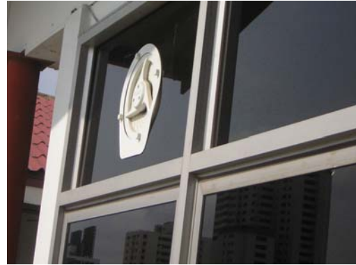
การติดตั้งพัดลมระบายอากาศ 1
