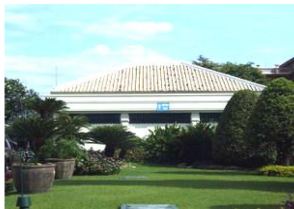
ฉ. อาคารห้องน้ำชาย
