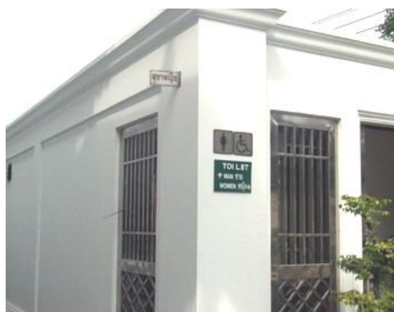
ฉ.อาคารห้องน้ำ
