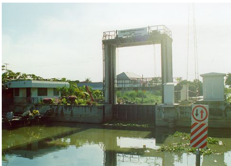
ภาพประกอบ 7 ประตูระบายน้ำ คลองบึงขวาง
