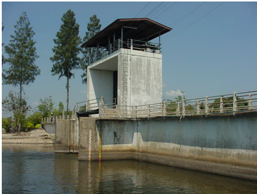
ภาพประกอบ 5 ประตูระบายน้ำ คลองสามวา
