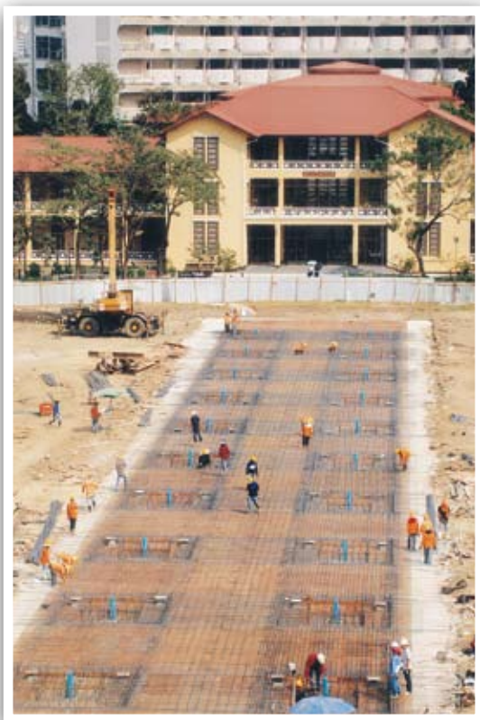
การก่อสร้างอาคารจอดรถใต้ดิน “มศว 60 ปี” และอาคารอนุรักษ “อาคารประสานมิตร” (2552)
