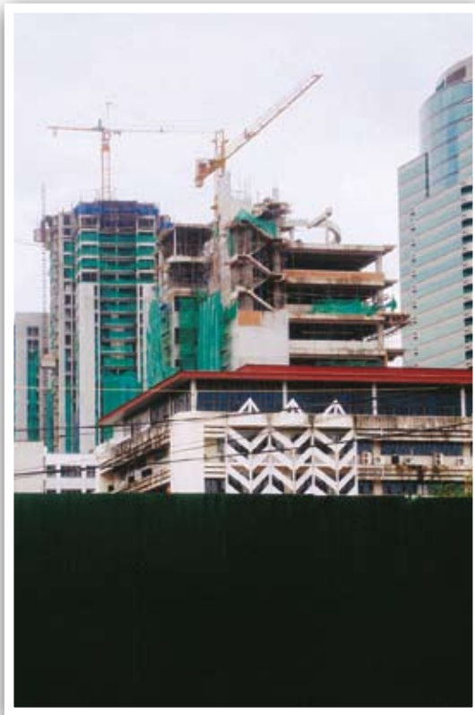
อาคารเรียนรวม “Learning Tower” หลวงสวัสดิสาร ศาสตรพุทธิ ขณะกำลังก่อสร้าง และอาคารหอสมุดกลาง ยังไม่ได้ปรับปรุงและทาสี (2551)
