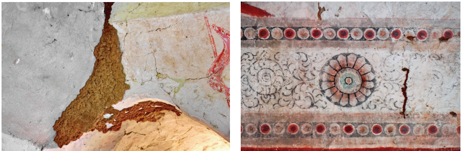
ภาพที่ 3.3 ปลวกทำรังและทิ้งทางเดินปลวกไว้บนจิตรกรรมฝาผนังภายในพระอุโบสถ
