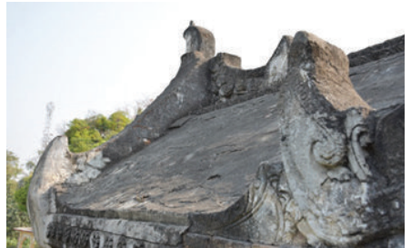
ภาพที่ 3.8 รอยแตกร้าวและการหลุดร่อนของปูนฉาบหลังคาพระอุโบสถ
