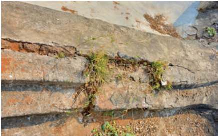
ภาพที่ 3.8 รอยแตกร้าวและการหลุดร่อนของปูนฉาบหลังคาพระอุโบสถ
