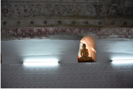
ภาพที่ 3.10 พระพุทธรูปปิดกั้นช่องแสงและช่องระบายอากาศ
