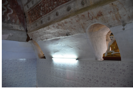
ภาพที่ 3.10 พระพุทธรูปปิดกั้นช่องแสงและช่องระบายอากาศ
