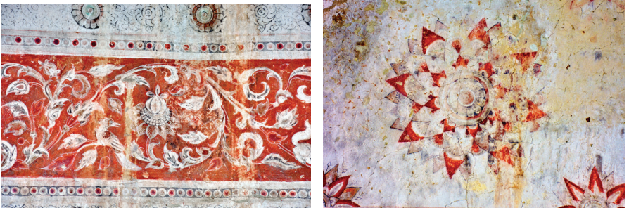
ภาพที่ 3.2 การชำรุดของจิตรกรรมฝาผนังที่เกิดจากการรั่วซึมของน้ำฝน
