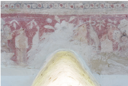
ภาพที่ 3.11 คราบสีที่เปอะเปื้อนบนจิตรกรรมฝาผนังภายในพระอุโบสถ
