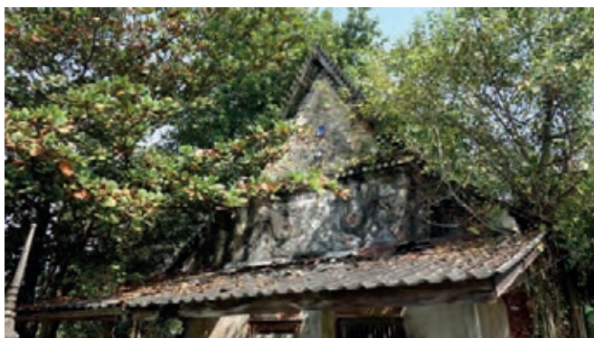
อุโบสถวัดหนองไก่อ่ (หลังเดิม) วัดสำคัญในพื้นที่ตอนใน ของหมู่บ้านคลองกระทุ่มแบน
