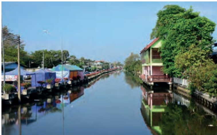
สภาพคลองภาษีเจริญในปัจจุบัน ไม่ได้ใช้เป็นเส้นทางคมนาคมเหมือนในอดีต
