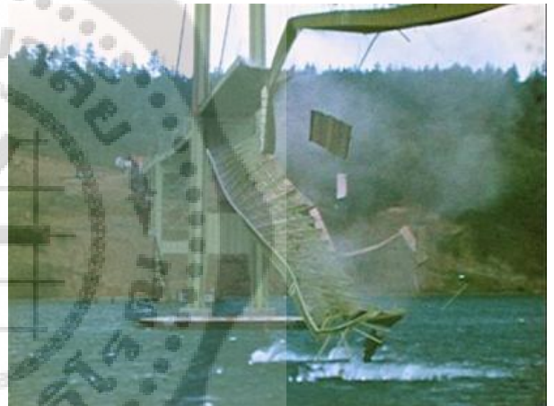
รูปที่ 1.8 วันที่ 1 กรกฎาคม พ.ศ. 2483 สะพาน Tacoma Narrows Bridge ที่ Puget Sound รัฐวอชิงตัน สหรัฐอเมริกา เปิดให้รถแล่นได้ แต่หลังจากนั้นเพียง 4 เดือนสะพานก็พังลงด้วยแรงลมที่มีความถี่เท่ากับความถี่ธรรมชาติของสะพาน
